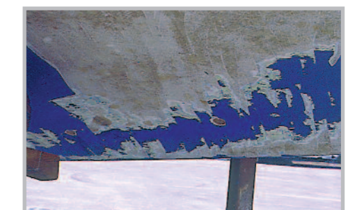
Tratamiento osmosis. Tratamento contra a osmose. Osmosis treatment.
