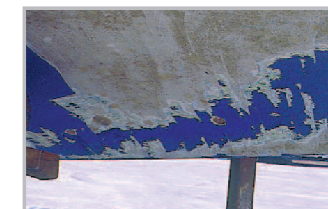
Tratamiento osmosis. Tratamento contra a osmose. Osmosis treatment.
