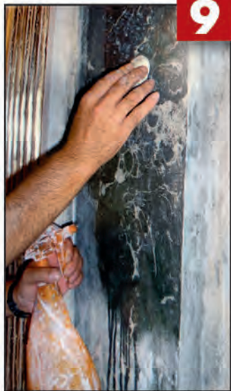
Aplicación de piedra pómez para hacer aflorar el vetado.
