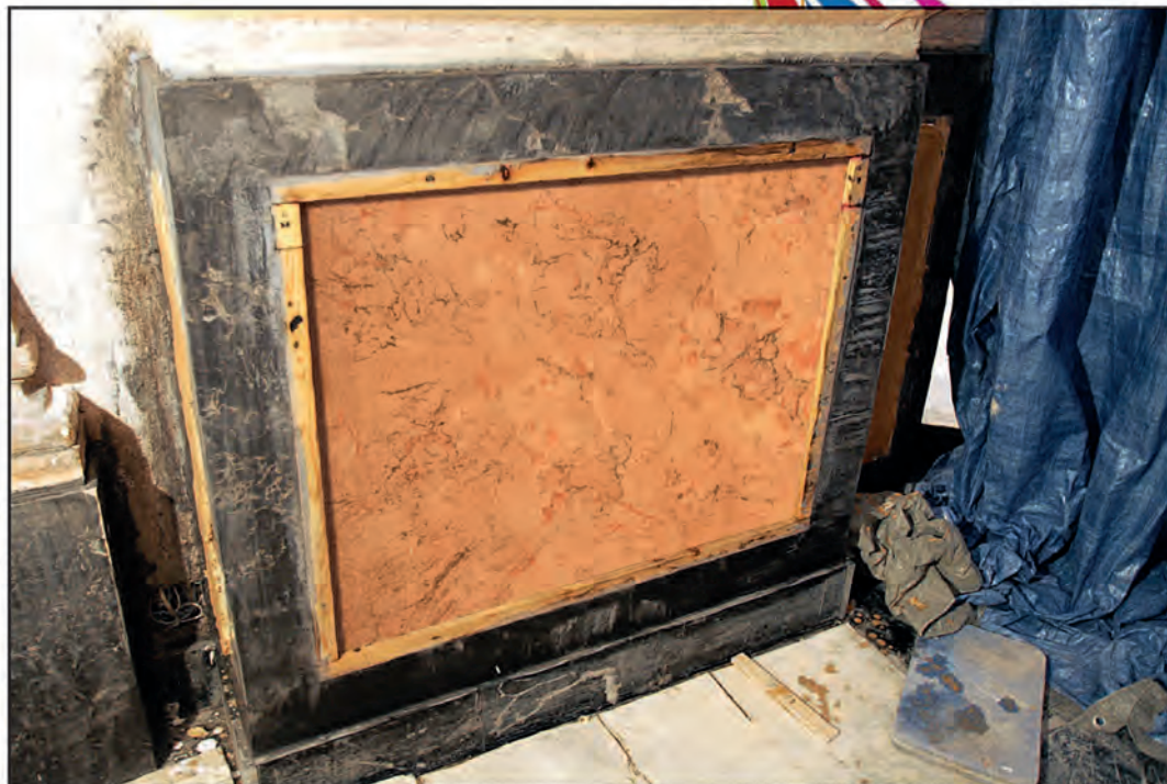
Aplicación de piedra pómez para hacer aflorar el vetado.
