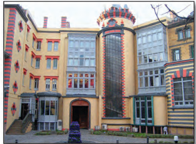
Palacio Chavarri Moyua. Fachadas y Rehabilitación.
