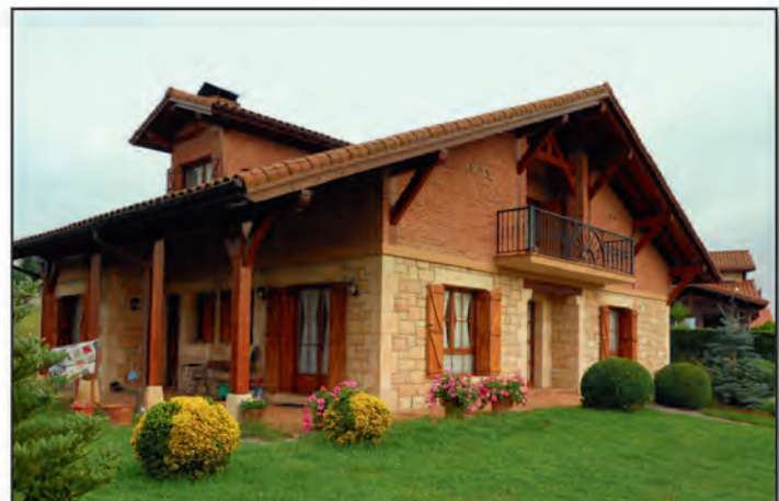
Caserío Gatika. Tratamiento de madera.
